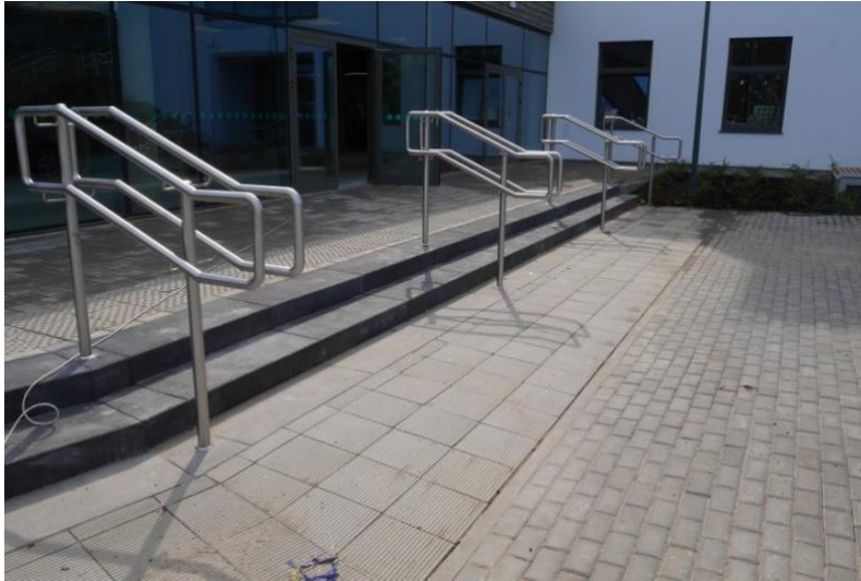
Rysunek 42. Prawidłowo wysunięte poręcze schodów poza pierwszy i ostatni stopień [fot.: M. Wysocki].
