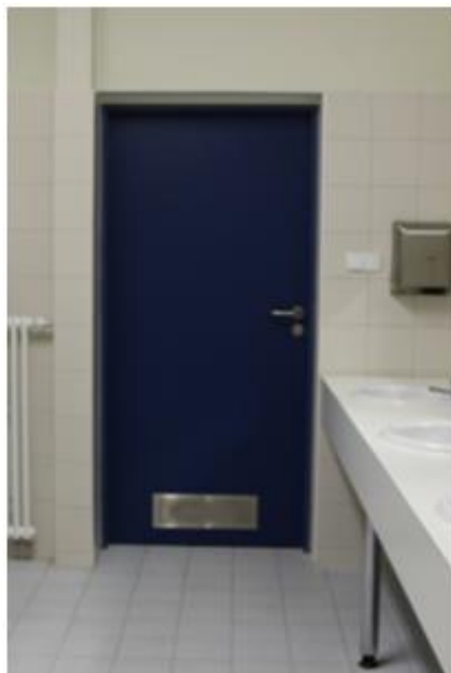
Rysunek 8B. Zmieniona kolorystyka drzwi w pomieszczeniu [fot. N. Ratajczak-Szponik].
