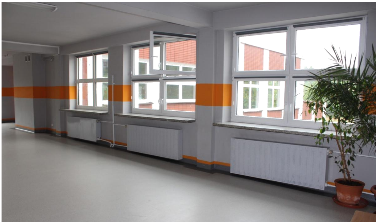
Rysunek 19. Przykład oświetlenia korytarza światłem naturalnym z okien usytuowanych wzdłuż ściany [fot. N. Ratajczak-Szponik].
