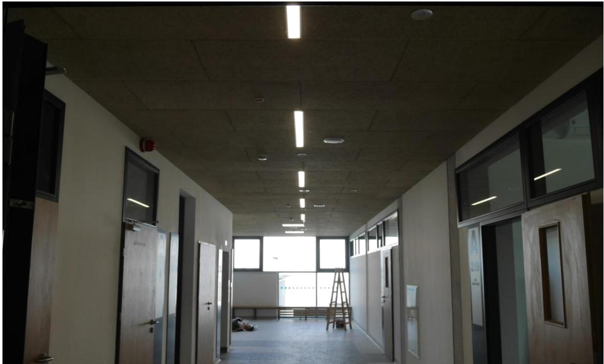
Rysunek 50. Przykład sytuowania oświetlenia sztucznego w sposób podkreślający kierunek przebiegu korytarza [fot.: M. Wysoki].
