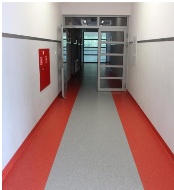
Rysunek 18B. Przykłady tworzenia kontrastów między ścianą a posadzką [fot. N. Ratajczak-Szponik].
