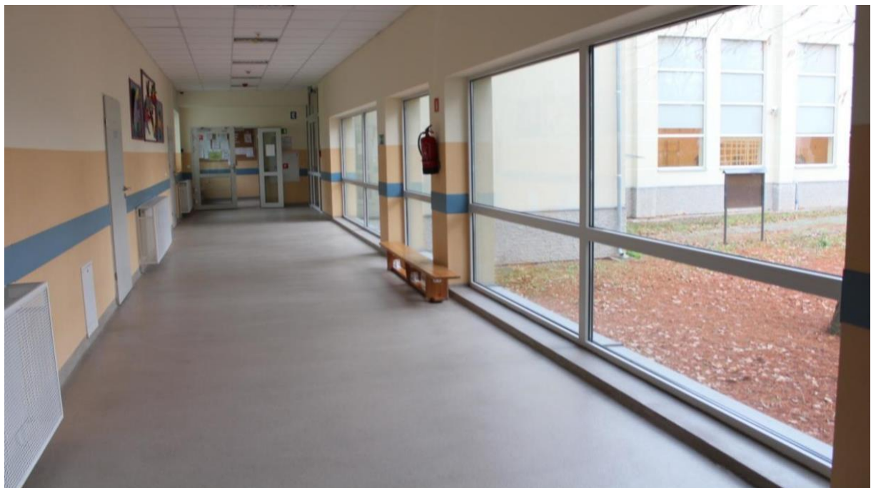
Rysunek 20. Przykład oświetlenia korytarza światłem naturalnym z okien usytuowanych wzdłuż ściany [fot. N. Ratajczak-Szponik].
