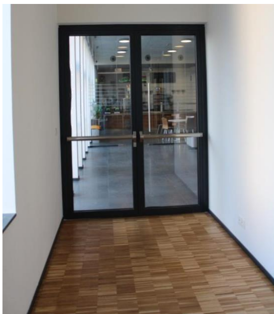
Rysunek 18A. Przykłady tworzenia kontrastów między ścianą a posadzką [fot. N. Ratajczak-Szponik].
